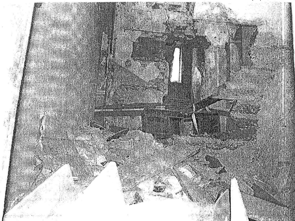
Фото № 5. Обвалена ділянка внутрішньої стіни та сходів.
