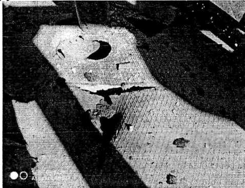
9. Осколкові попадання в живильний трубопровід ГРС.
